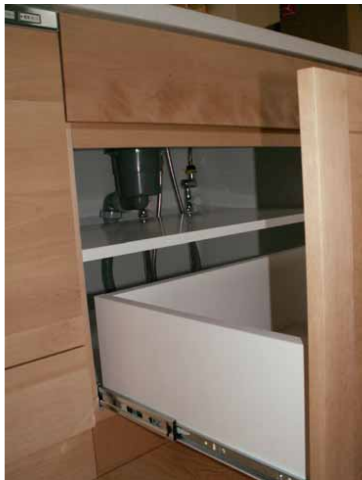
シンク下引き出し状況。短尺排水トラップ下の棚板は可動棚です。
