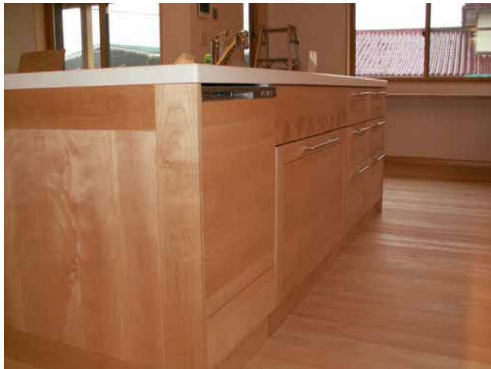
手前から食洗機、シンク下引き出し、3段引き出し
