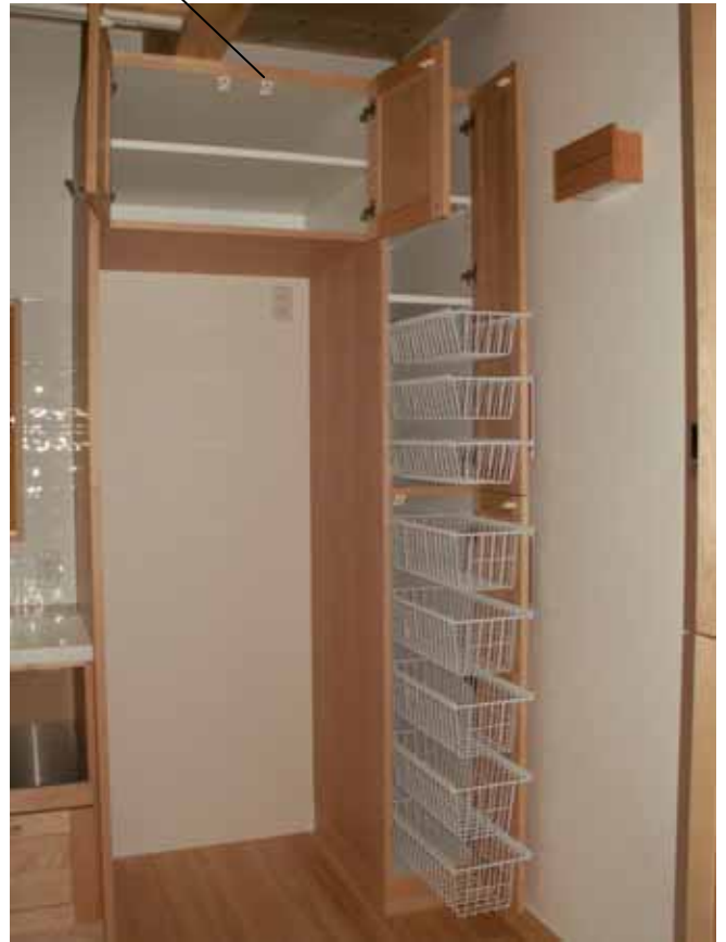
ワイヤーバスケット設置、深さ2種類。
