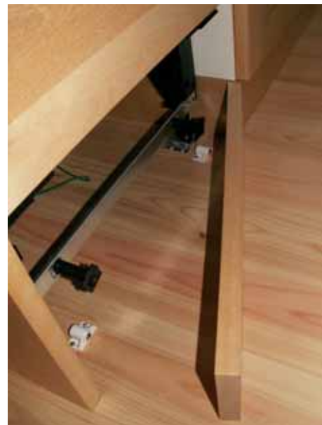
食洗機の台輪部取り付け状況 マグネットにて脱着。
