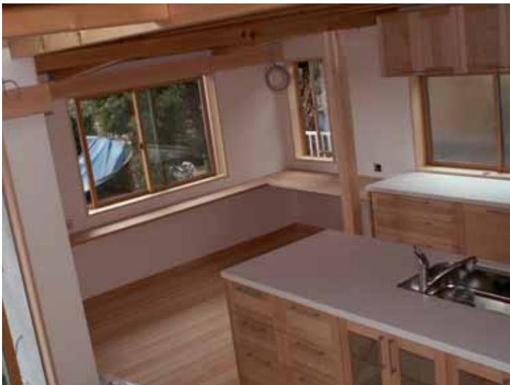
L字カウンター収まり状況。
