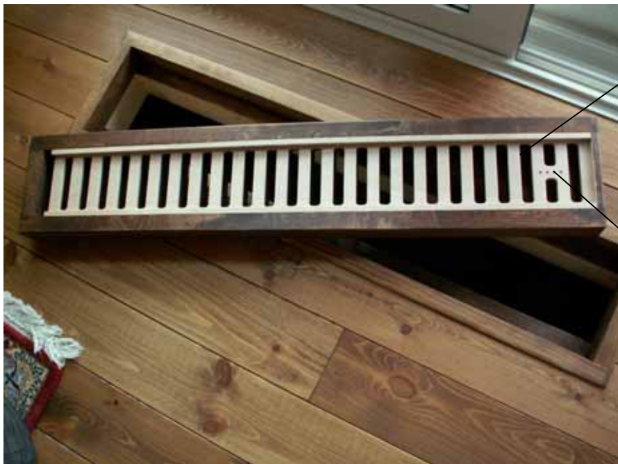
アルダー無垢ルーバ-スライド板 取り付け状況 (裏側)
