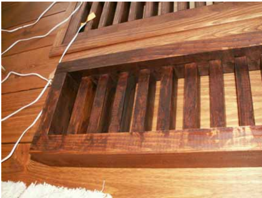
既設ルーバ-枠裏側状況。
