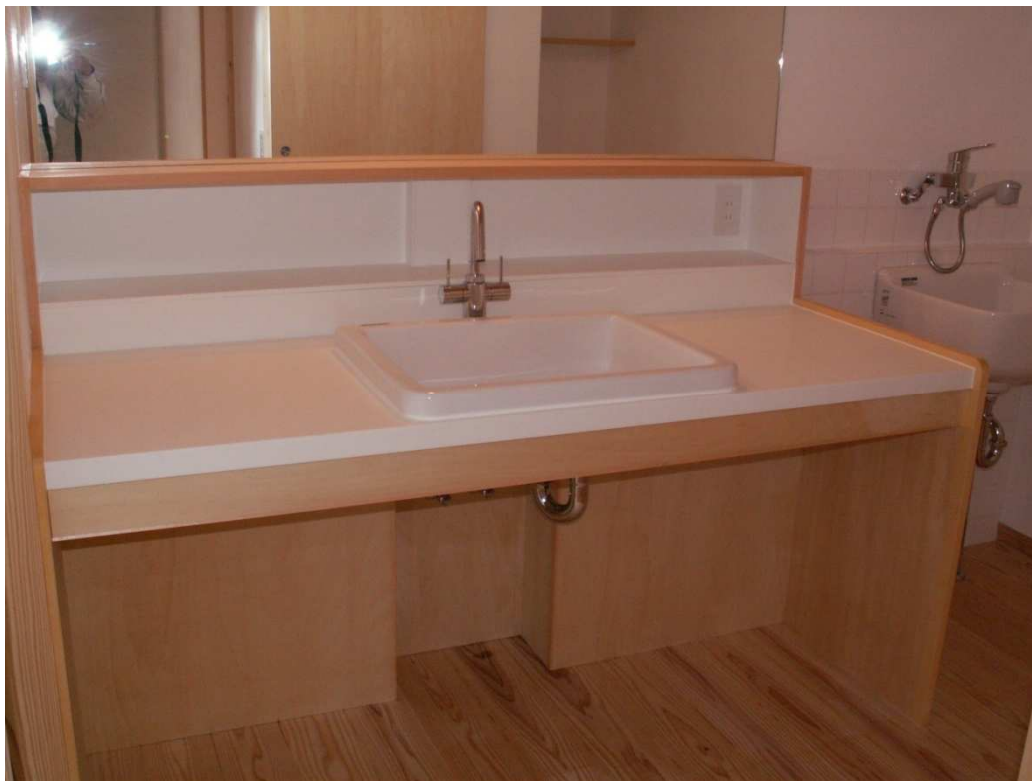
洗面台取り付け完了です。
