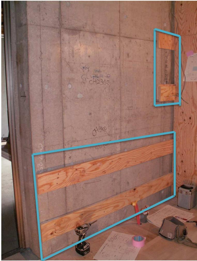
RC 構造のため洗面台の壁固定部はあらかじめ、固定用芯材を取り付ける。
